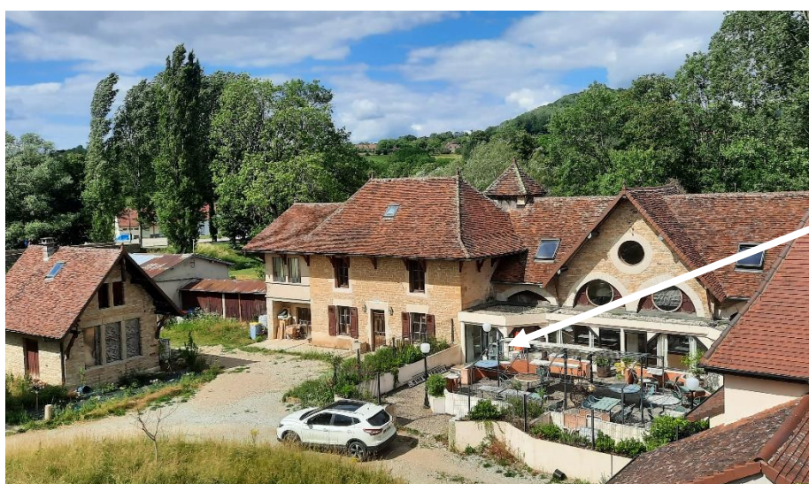
L'entrée dans le bâtiment sous le porche
